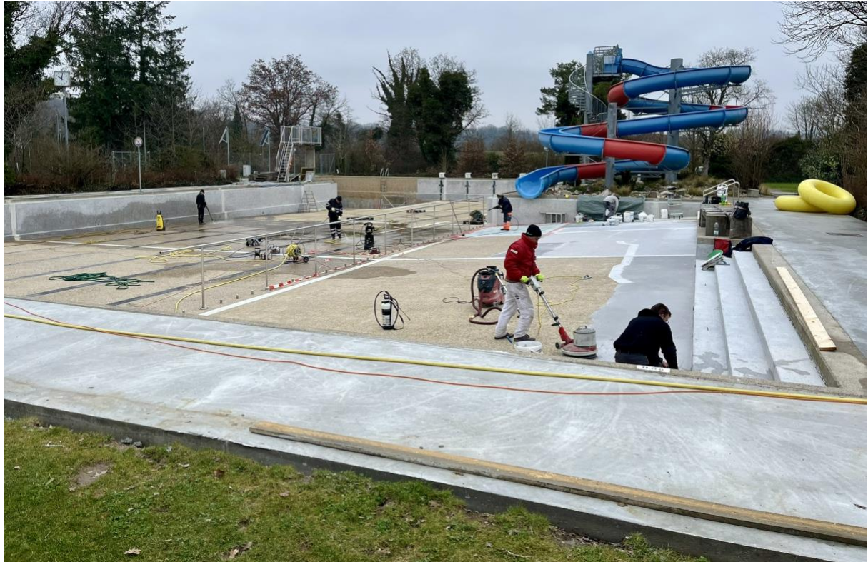
Weichenstellung für die nächsten 10 Betriebsjahre: Renovation des Aussenbeckens (Foto: R. Mainzer)
